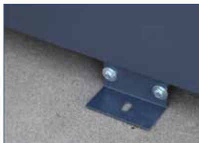
Klammern zur Verankerung am Boden.
