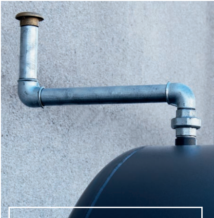
Entlüftungsrohr mit 2,40 mt.
